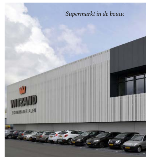
Het nieuwe bedrijfsgebouw strekt zich uit over 5.000 m 2 .
